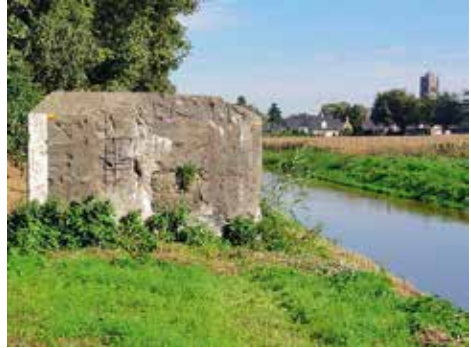
Het defensiekanaal met kazemat in de buurt van Mill
